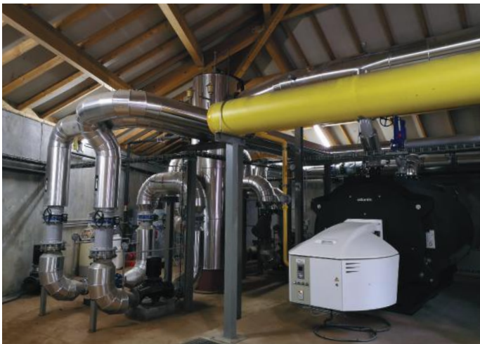
Chaudière à gaz au Centre sportif Richard Bozon
