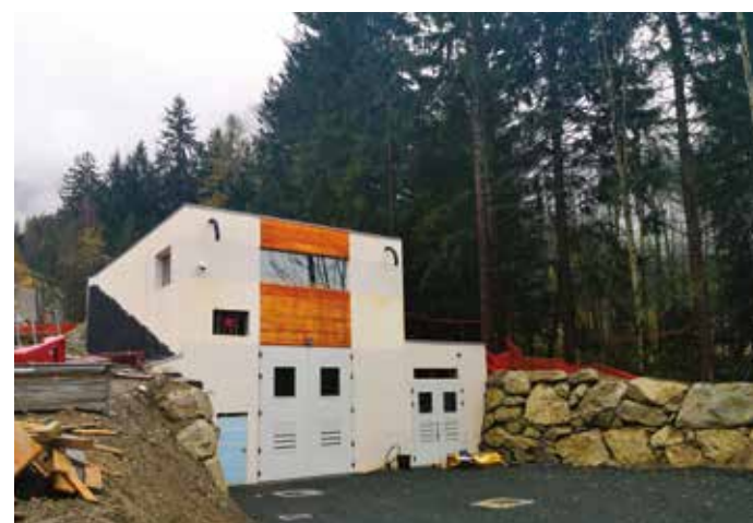
Centrale hydroélectrique de Taconnaz
